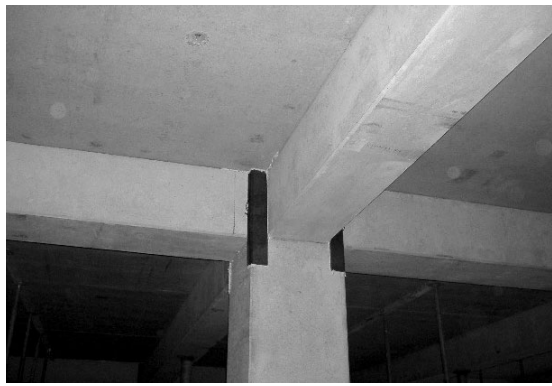
[그림 5] Steel Form 설치
