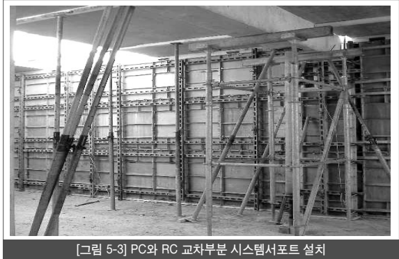
[그림 5-3] PC와 RC 교차부분 시스템서포트 설치
