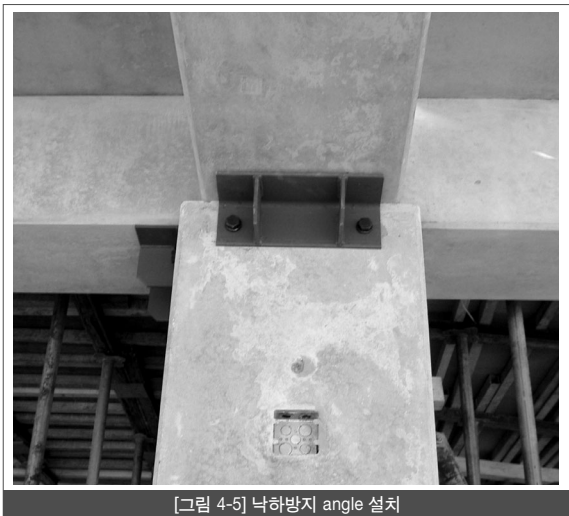
[그림 4-5] 낙하방지 angle 설치
