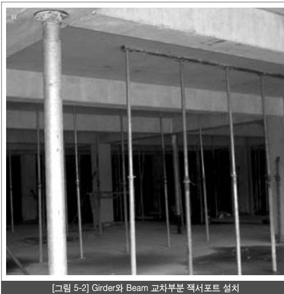
[그림 5-2] Girder와 Beam 교차부분 잭서포트 설치
