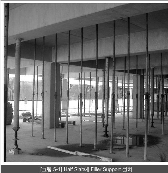
[그림 5-1] Half Slab에 Filler Support 설치
