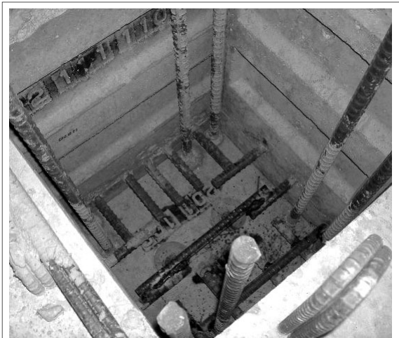
[그림 4-4] 기둥과 보 철근 용접
